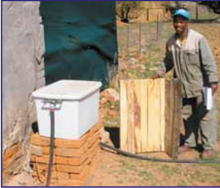
'n Eenvoudige maar doeltreffende waterstelsel met balklep word gebruik om water te voorsien aan die lamhokke. Let op die houtbedekking vir die watertank om teen son te beskerm, en die spoelpyp wat regs uitloop. Hiermee kan die vuil water uit die drinkbakkies dreineer word sodat skoon water altyd beskikbaar is
